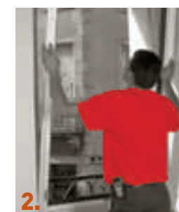
2. Mise en place de la nouvelle menuiserie.
