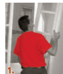
1. Dégondage des ouvrants.
